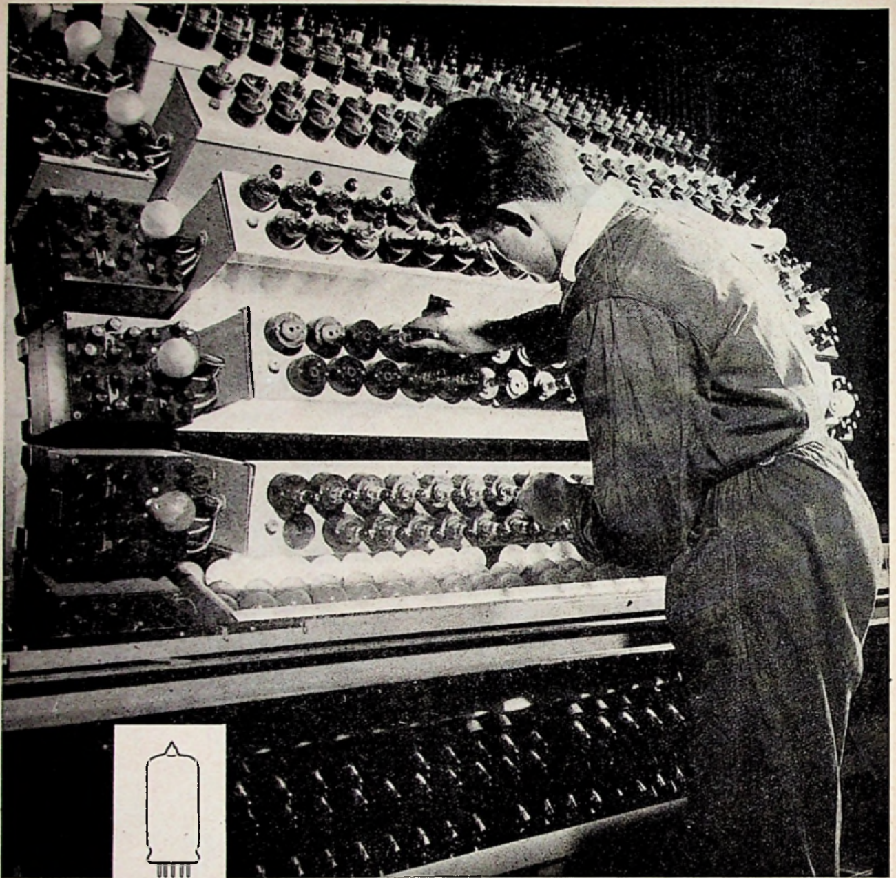
Het formeren van elektronenbuizen
